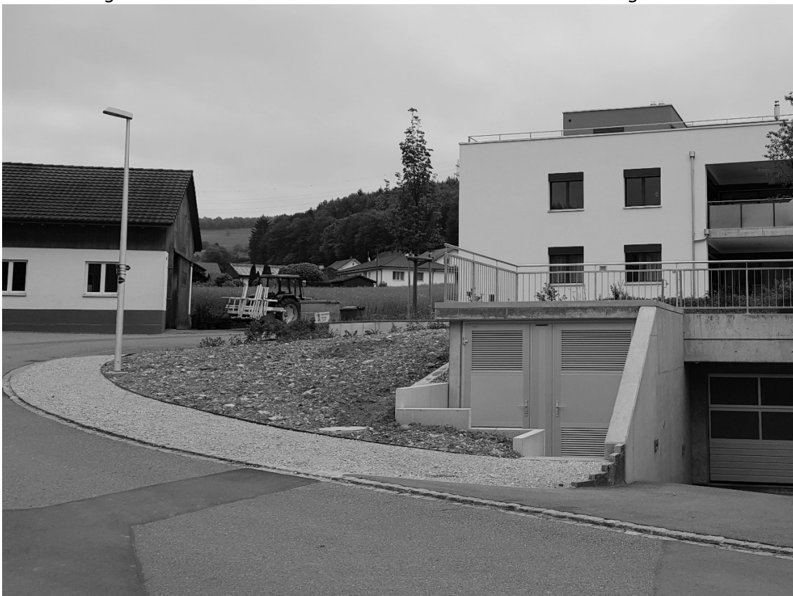
TS 70 Wil Oberdorfstrasse
