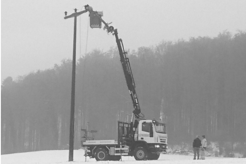
Demontage der Freileitung in Hagenfirst
