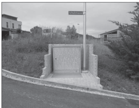
Ersetzter Stromverteiler Schulstrasse
