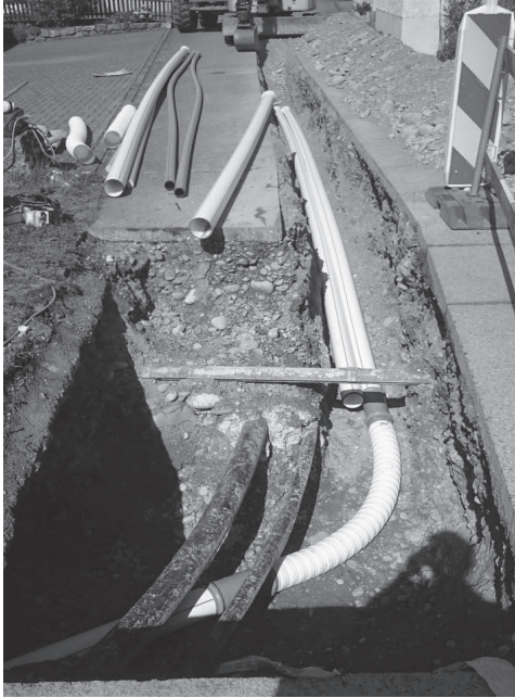
Bild: Trassenbau im Hegi Erweiterung der bestehenden Trasse um drei weitere Kabelschutzrohre
