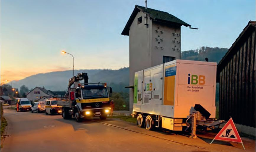
Austausch der Mittelspannungsanlage. Rechts auf dem Lastwagen die alte Anlage (Baujahr 2000), links am Kran die Neue.
