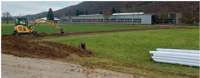
Für die Erschliessung der noch unbebauten Parzellen am Altweg, musste ab Transformatorstation Mökli eine neue Trasse erstellt werden.
