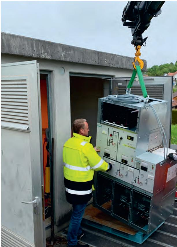
Einbau der neuen Mittelspannungsanlage in der Transformatorstation Strickstrasse in Reuenthal.
