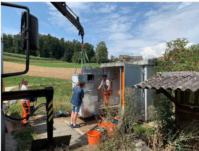
Austausch der MS-Anlage in der Trafostation Hagenfirst.
